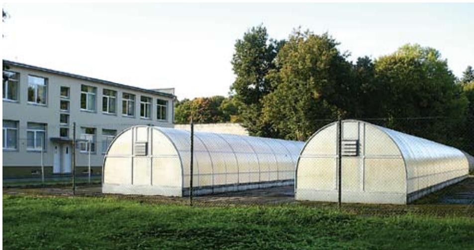
Modernus su automatine įranga, skaidrių polycarbonato lakštų dangos Nomeko AB (Švedija) šiltnamiai
