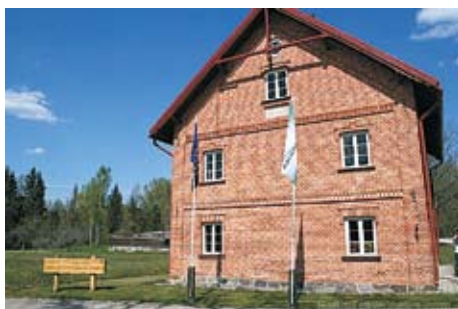
1895 m. statyta Vištytis kankorėžių aižykla
