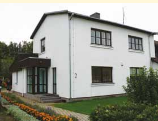
Renovuota Anciškių girininkijos būstinė
