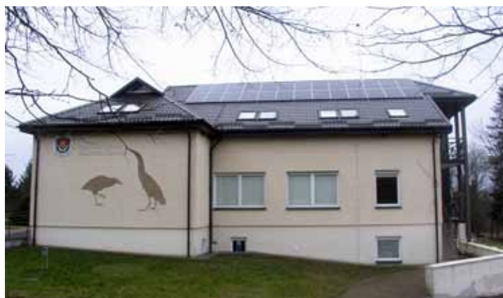
Varnių RP direkcijos administracinis pastatas
